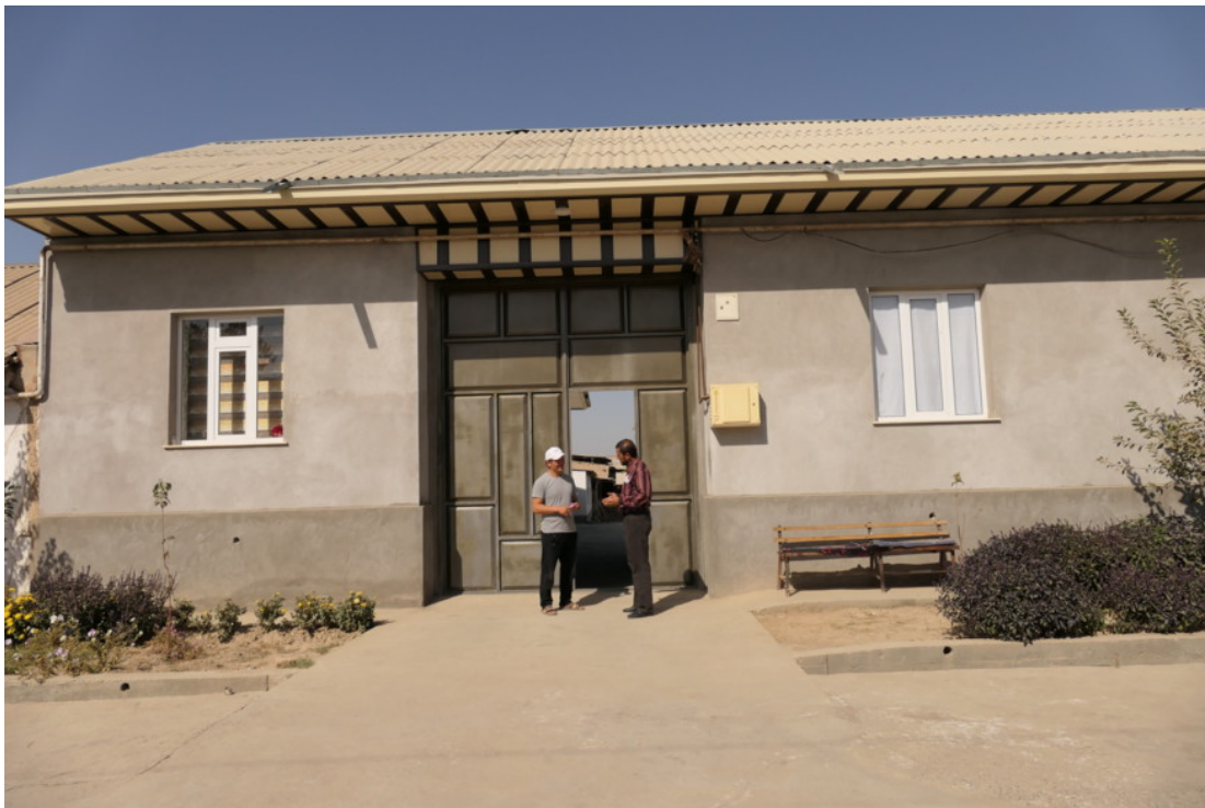
Abb. 16: Ein durchschnittliches Wohnhaus, hier bereits mit Isolierglas in den Fenstern, in der Grundsubstanz aber oft weiterhin aus mit Zementputzten geschützten Lehmziegeln. Statussymbol ist häufig das große metallene Tor.
