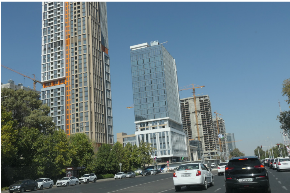
Abb. 8: Gewaltige Investitionen werden derzeit in den urbanen Zentren getätigt (hier: Taschkent).
