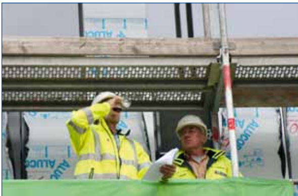
Gute Wünsche vom Polier – die Bauarbeiten liegen im Zeitplan
