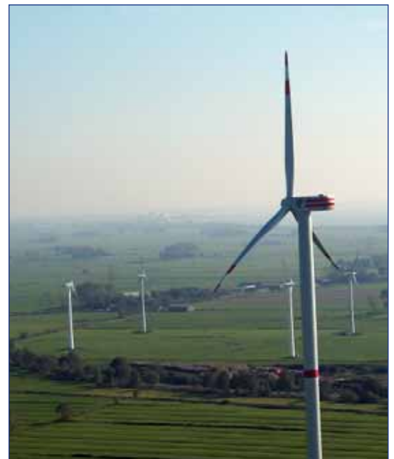
Gigant in der Landschaft: die Repower 5M im Windpark Büttel
