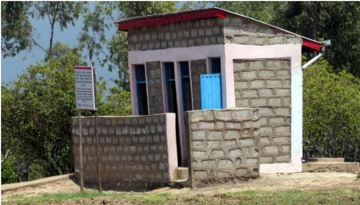
Abb. 11 (links): In 17 von 20 Schulen des StC-Projektes in Sidama wurden nach Geschlechtern getrennte Doppel-VIP-Latrinenblöcke errichtet.
