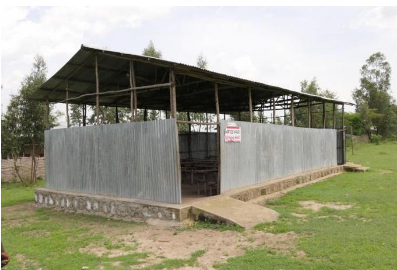
**Abb. 9: Vom StC-Project errichteter Hangar aus Wellblech im Woreda Boricha zur Verwendung als Kantine für die Schulspeisung in Sidama.**
