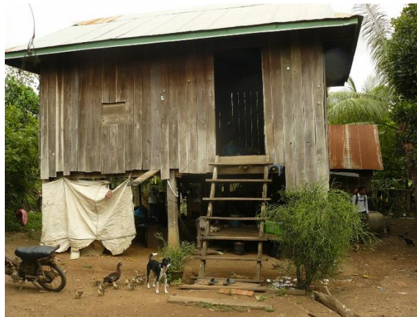
Foto 1: Sehr einfaches, dennoch stabiles Haus in einem der NeusiedlerInnenhöfen in Kampong Chhnang
