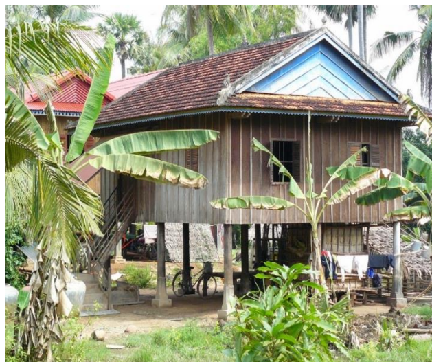
Foto 1: Holzhaus, wie es in ganz Kambodscha typisch ist, neuerdings aber eher mit Wellblech als mit gebrannten Ziegeln gedeckt.
