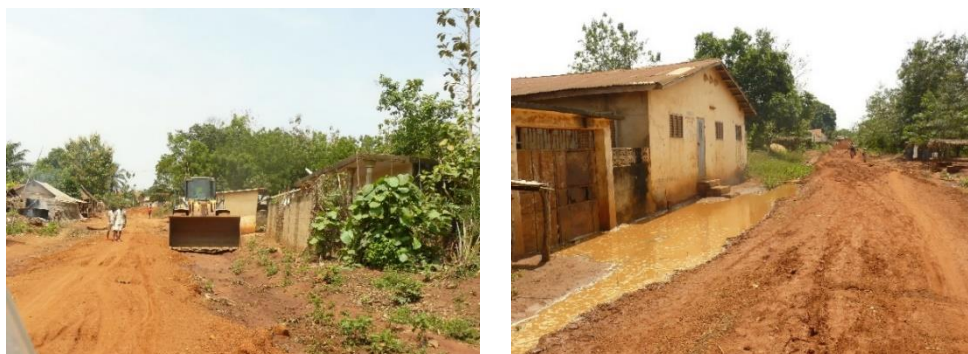
Abb. 8 und 9: Pistenbau im Rahmen von PAIA-VO
