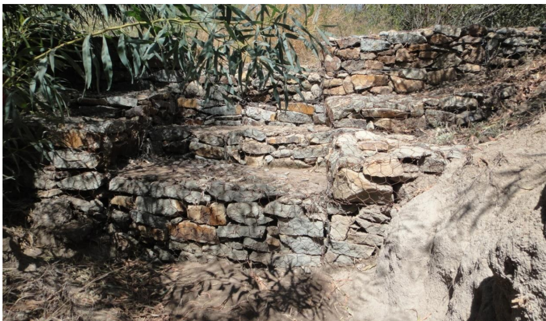
Abb. 5: Verbau eines Gullies mit Hilfe von Gabionen
