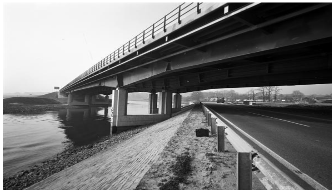
Figure 28 - Middachterbrug (Middachter bridge) in 1974 (Rijkswaterstaat)
