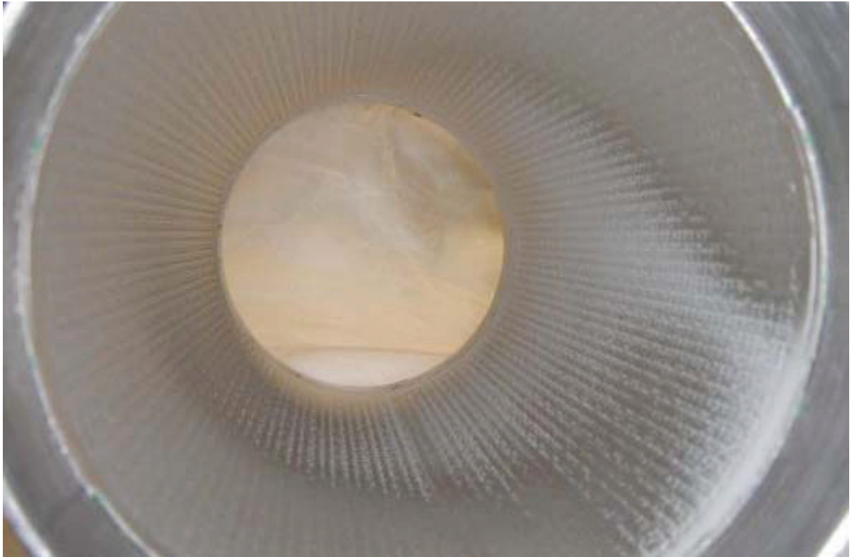
Abb. 4.7-2: Oberfläche der Beschichtung des Membranrohrmoduls
